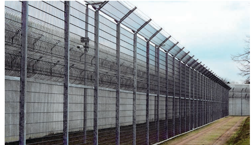
Im rheinland-pfälzischen Ingelheim unterstützt die Diakonie Menschen in Abschiebungshaft. Das Haftgebäude gleicht mit seiner 5 Meter hohen Betonmauer und dreifachem Stacheldraht einem Hochsicherheitsgefängnis, das die Insassen von der Außenwelt trennt.
