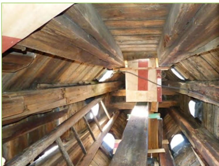
Einbau der Dohlenkästen im Johannesturm
