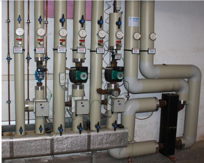
Messungen Rücklauf temp. (T1) vor und nach hydr. Weiche (T2) über 1 Woche
