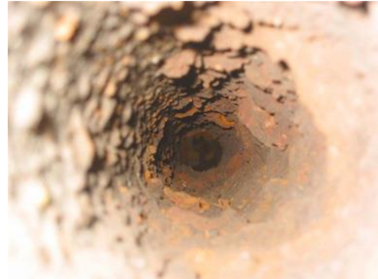
Innenansicht eines Stahlrohres DN 100
