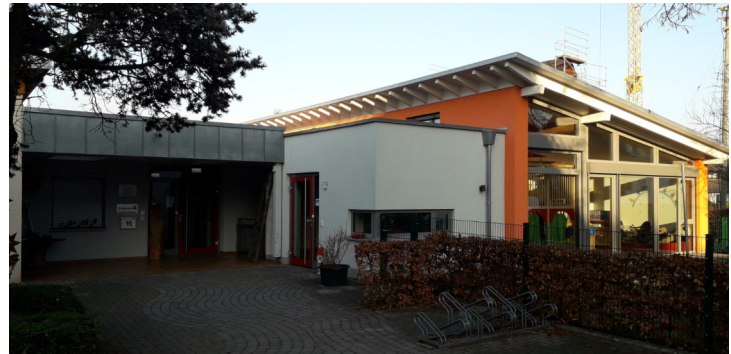
Eingang Kita Pfistergässle und rechts Anbau Kleinkindgruppe
