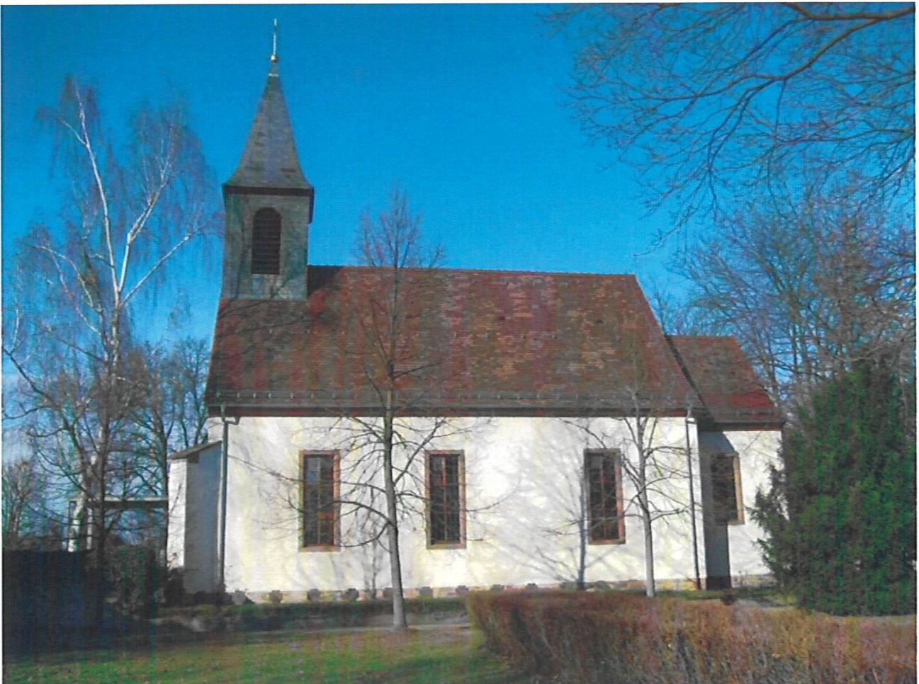
Die Laurentiuskirche (Südseite)
