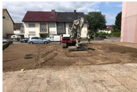
Einbringen des Mutterbodens
