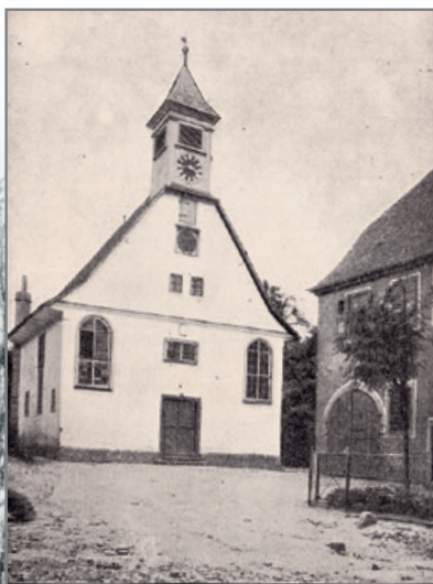
Kirchlein in Palmbach. Nach einer photographischen Aufnahme durch Bauzeichner Joh. Eric in Ulmthalen.
