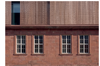
Collage Fassade Übergang Altbau und Dachaufbau
